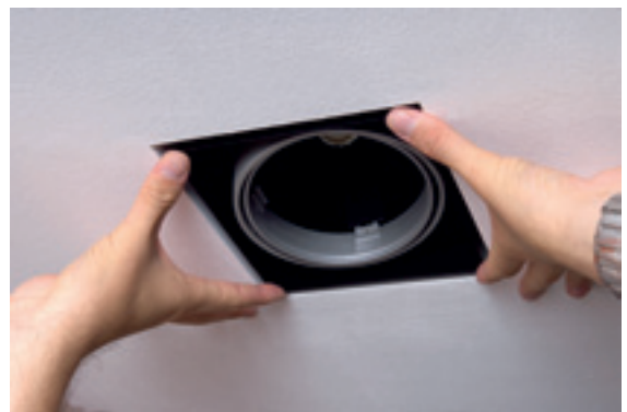
Einsetzen und Ausrichten des Leuchtengerätes im Einbaurahmen mittels Stellschrauben.
