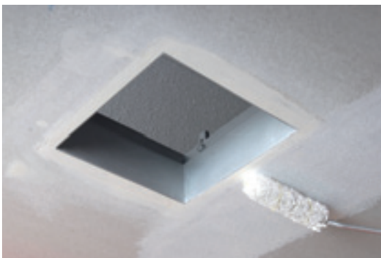
Nach dem Abschleifen Überstreichen mit Wandfarbe. Der Einbaurahmen kann nach geeigneter Grundierung ebenfalls mit Wandfarbe gestrichen werden.
