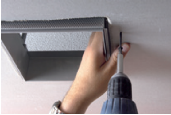
Verschrauben des Einbaurahmens im Deckenausschnitt mit dem rückseitigen Siebblech.
