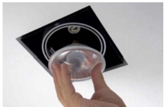
Einsetzen des Leuchtmittels.
